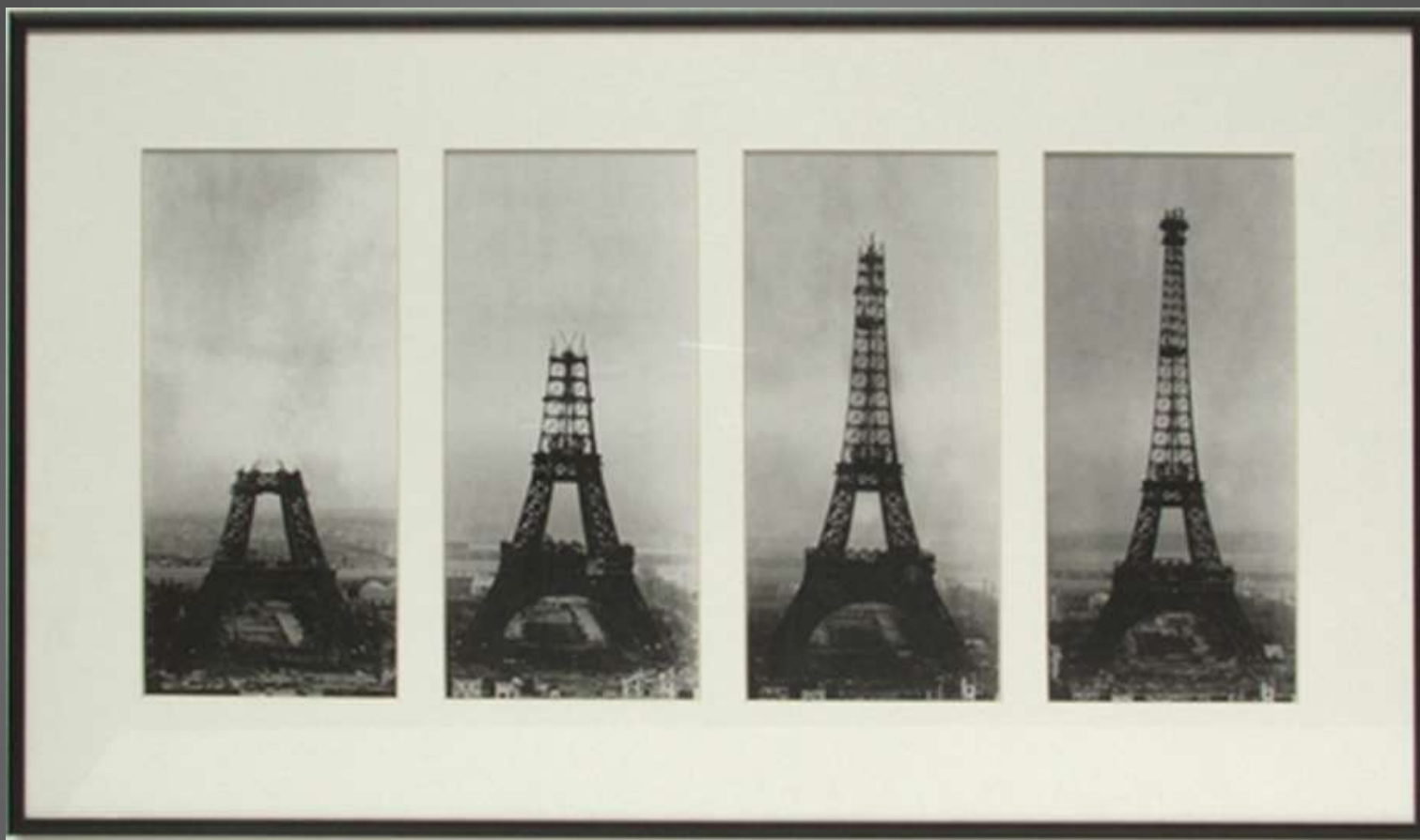
Obr. 8 Stavba Eiffelovy věže
