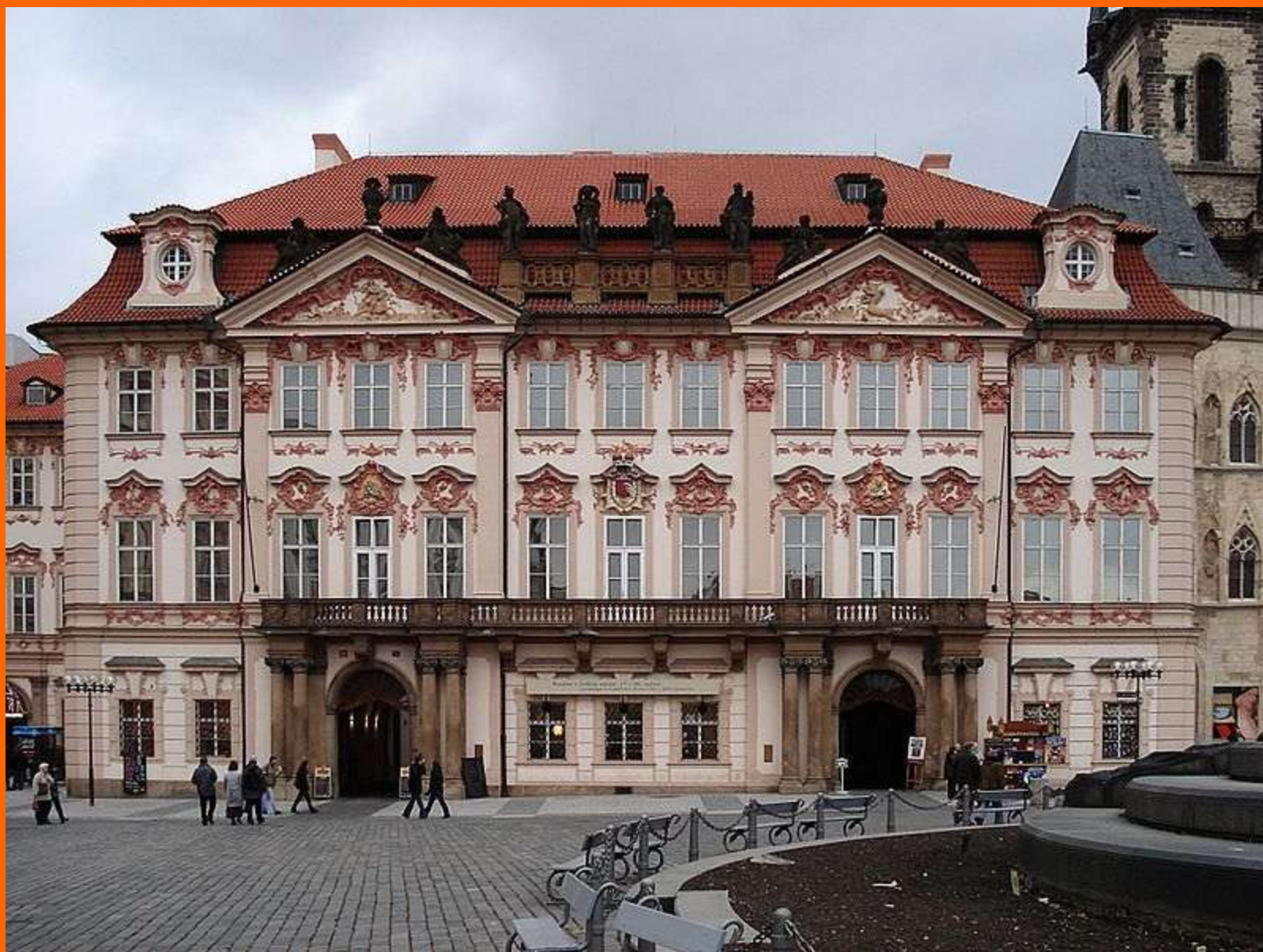
Obr. 5 Palác Kinských s mansardovou střechou
