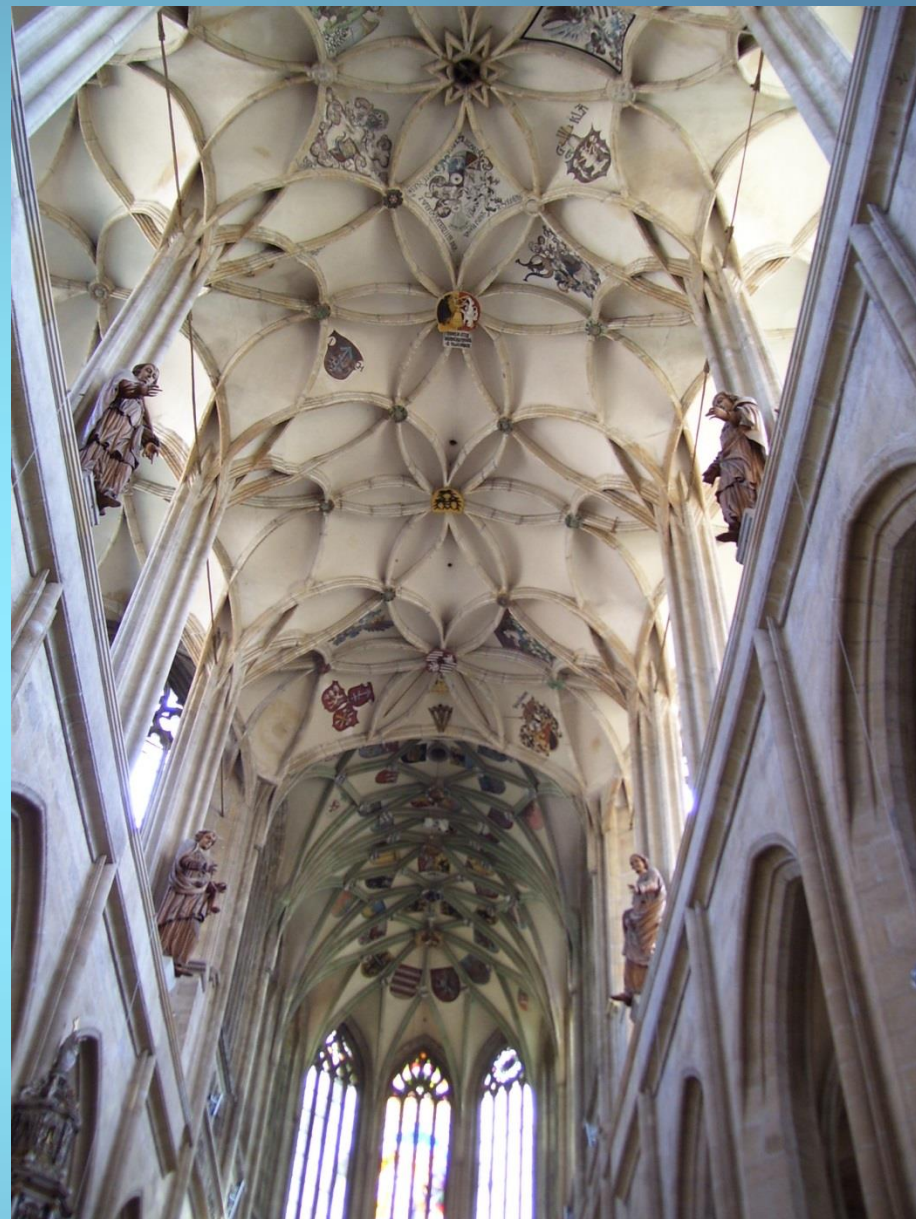
Pohled na klenbu hlavní lodi
