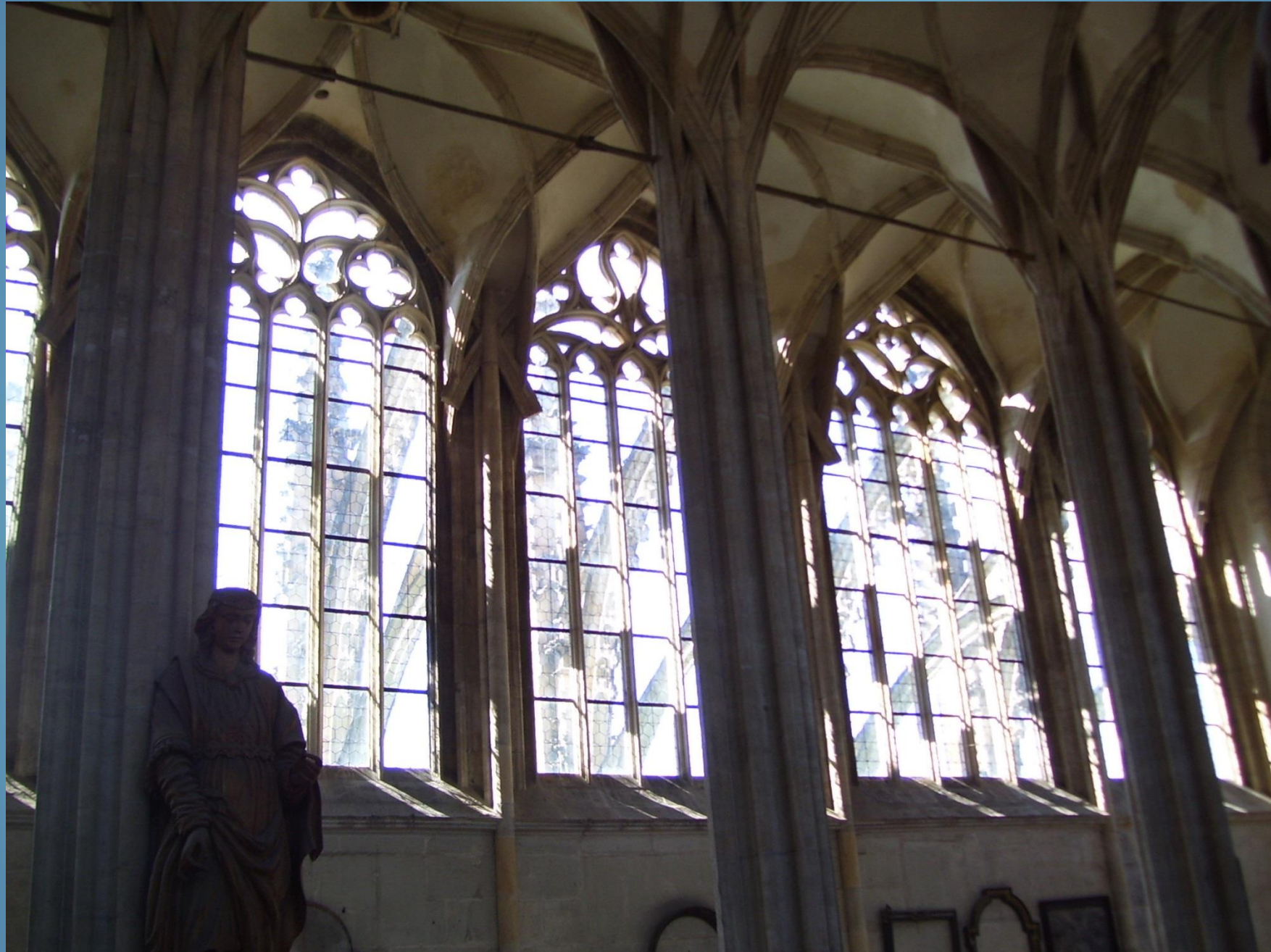
Pohled na opěrný systém přes okna, z ochozu
