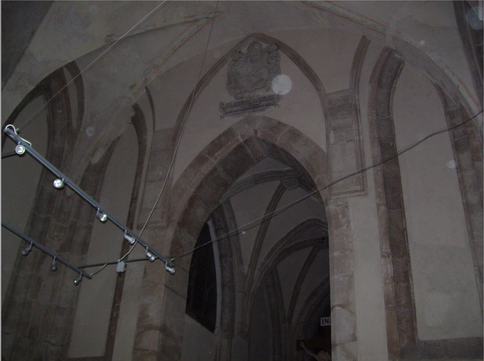
POHLED DO HORNÍ KAPLE
